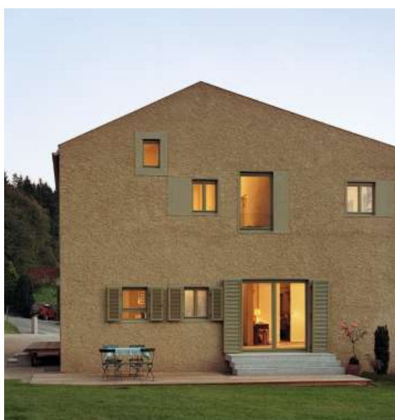
Wohnhaus aus Ziegelmauerwerk mit einem grobkörnigen, sandgelben Putz, der von Hand angeworfen wird.
